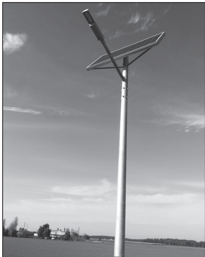
W Starym i Nowym Belęcynie uzupełniono oświetlenie uliczne. Stary Belęcin wzbogacił się o dwie dodatkowe lampy solarne, a Nowy Belęcin o jedną. Teraz będzie jaśniej i bezpieczniej.
